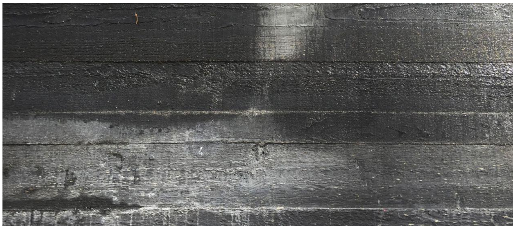
Рис. 2. Бетон с текстурой брашированной доски
