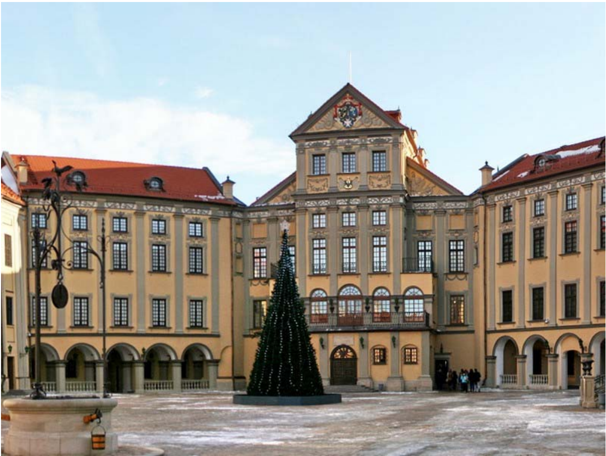
Рис. 25. Дворцово-парковый ансамбль в Несвиже, внутренний двор.
