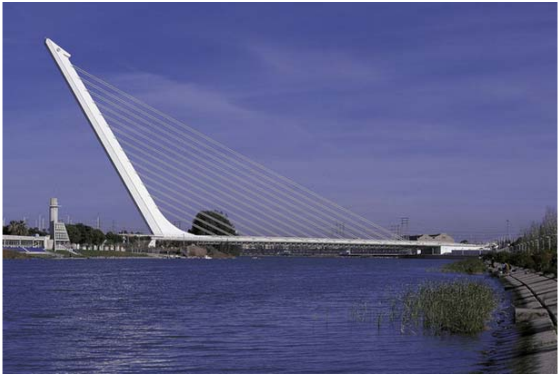
Рис. 96. Мост «Аламильо», Севилья, Испания. Арх. Сантьяго Калатрава
