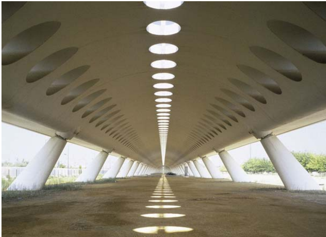
Рис. 97. Мост «Аламильо», Севилья, Испания
